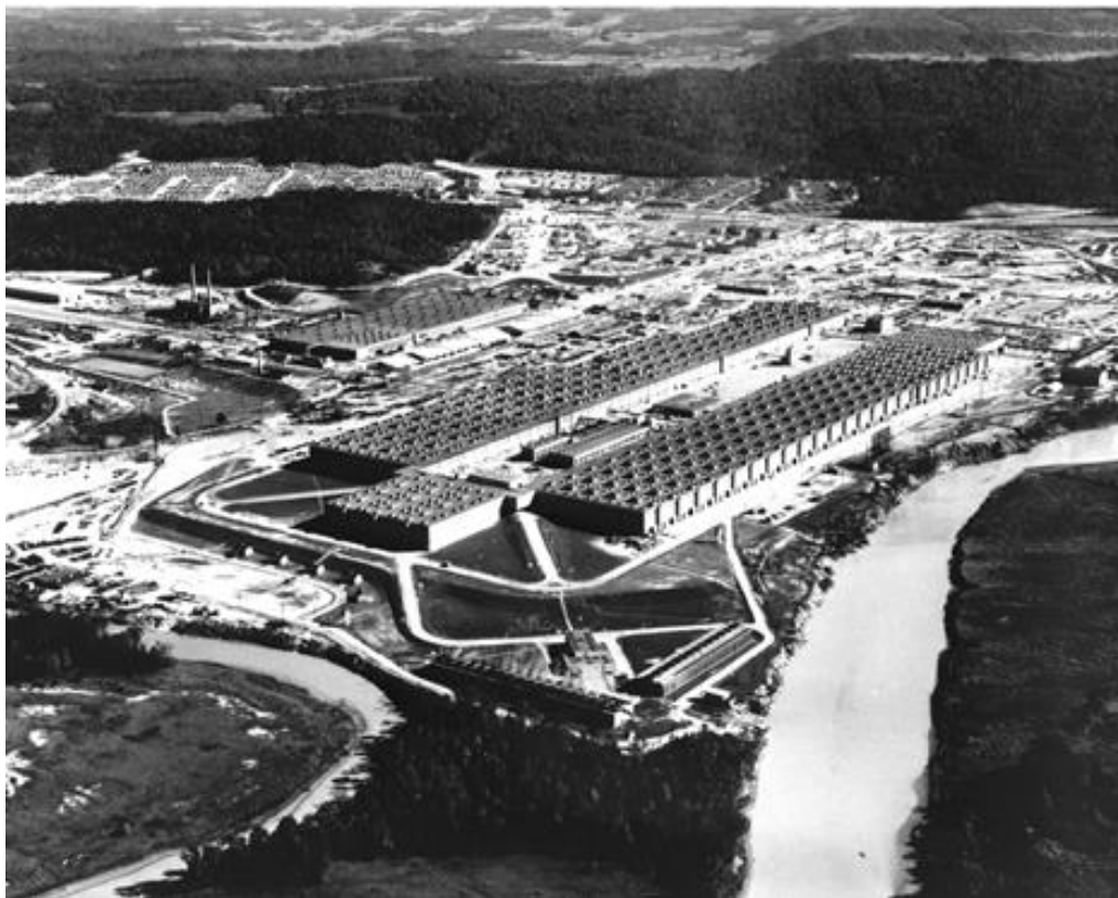
Рис. 3.36. Первый в мире завод по обогащению урана методом газовой диффузии (завод К-25, Ок-Ридж, США)
