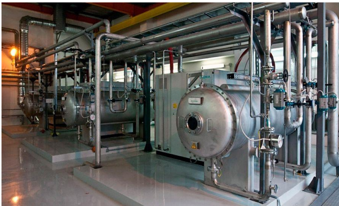
Рис. 4.5. Озонаторная на блоке К-6 Южной водопроводной станции Санкт-Петербурга
